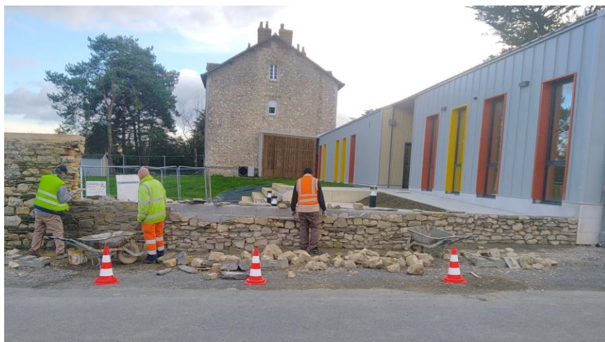
Réalisation d'un muret (parpaing et pierre) au périscolaire pour la Commune de St Vincent des Landes.
