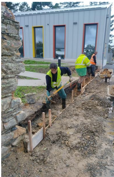
Réalisation d'un muret (parpaing et pierre) au périscolaire pour la Commune de St Vincent des Landes.
