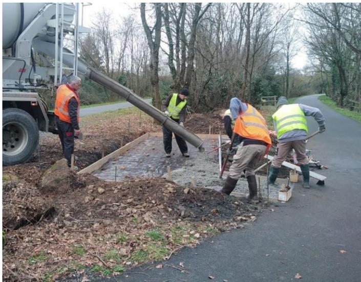
Réalisation d'une dalle en béton armé avant la pose d'une table de pique-nique (accès PMR) sur la voie verte pour la CCCD.
