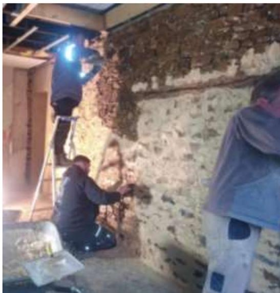
**Travaux de rénovation de maison en intérieur : maçonnerie d'une ancienne ouverture, piquage et jointoiement du mur en pierre chez un particulier à Saint-Aubin-des-Châteaux**
