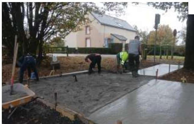
Réalisation d'une dalle béton pour la pose d'une table de pique-nique et d'une rampe d'accès PMR aux abords de la voie verte Châteaubriant-Soudan pour la CCCD
